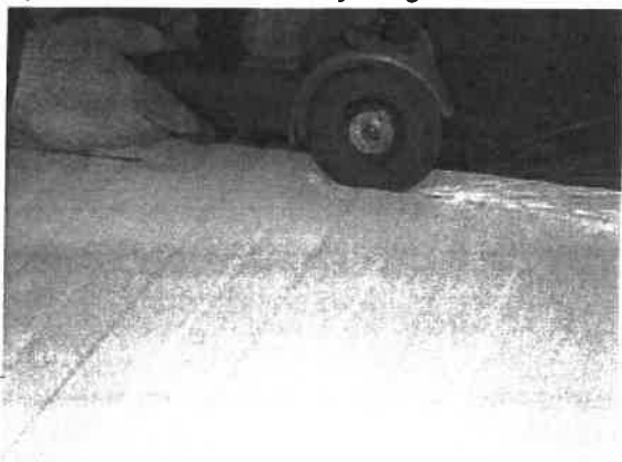
Imaginea 2. Nu tăiați panourile cu polizoare unghiulare, deoarece se pot strica învelișurile de protecție anticorozivă
